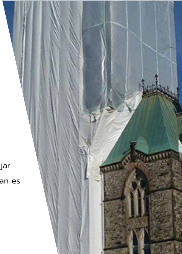
Fabricado con material de polietileno tejido.
