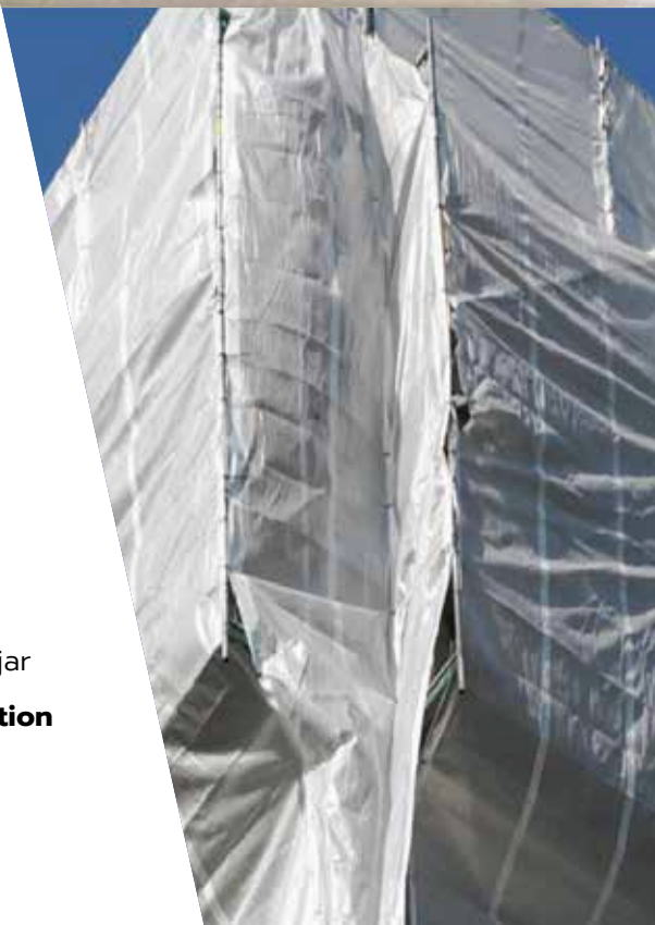
Fabricado con tejido de polietileno recubierto.
